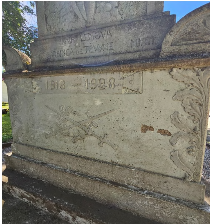
9. Paminklo pirmo tarpsnio paviršiuje padengtas purvu, užtrynimo sluoksniu atšokimai, skilimai, cementacijos praradimas.
