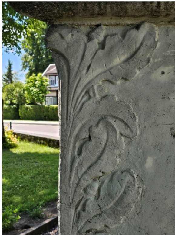
12. Paminklo pirmo tarpsnio paviršiaus užtrinimo sluoksniu smulkūs skilimai, krakeliūros.
